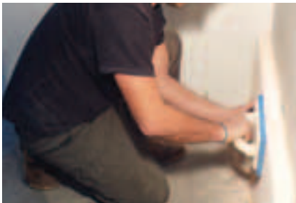
Battere la superficie con frattazzo di spugna facendolo aderire completamente
