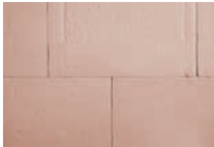
Eeguire la posa dei pannelli a giunti sfalsati
