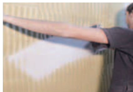
Applicare la rete di armatura
