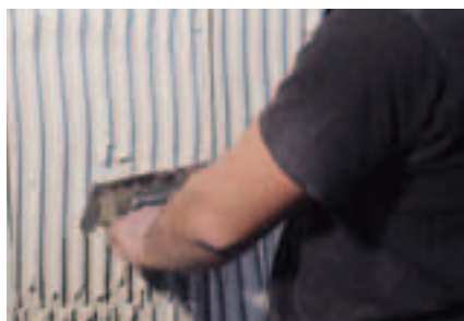
Stendere la malta Rasapor Natur con spatola dentata da 10 mm
